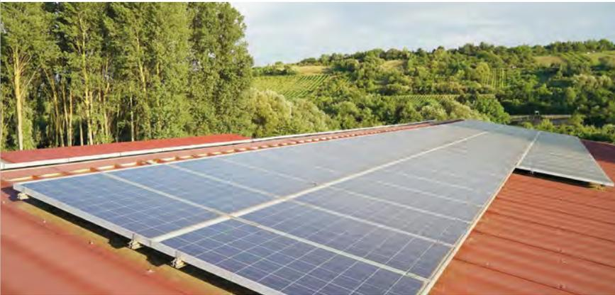
Nachhaltige Energiegewinnung durch Photovoltaik. 40 % des erzeugten Stroms werden direkt im Weingut verbraucht. Durch das Verbrennen von Rebholz im Winter konnte der Heizölverbrauch um 70 % reduziert werden. Im Neubau des Wohnhauses mit Büro ersetzt eine solarbetriebene Wärmepumpe den alten Ölheizkessel.
